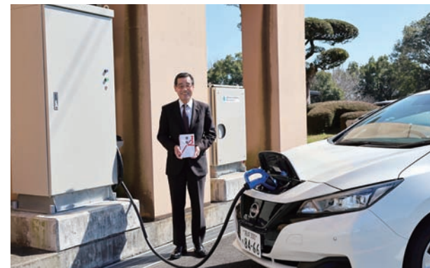
町が導入している蓄電池と電気自動車（EV）
