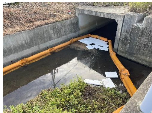
オイルフェンスの設置状況
