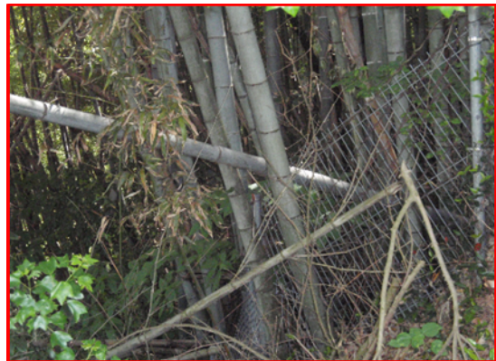
↑高速道路沿線より倒れこんだ竹
