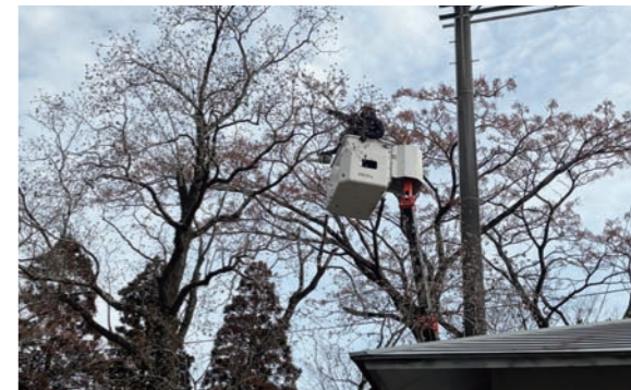
照明にかかった支障木を作業車の中から伐採を行う
