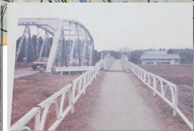
旧太田原橋に隣接する歩道
