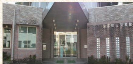
国富町立図書館
