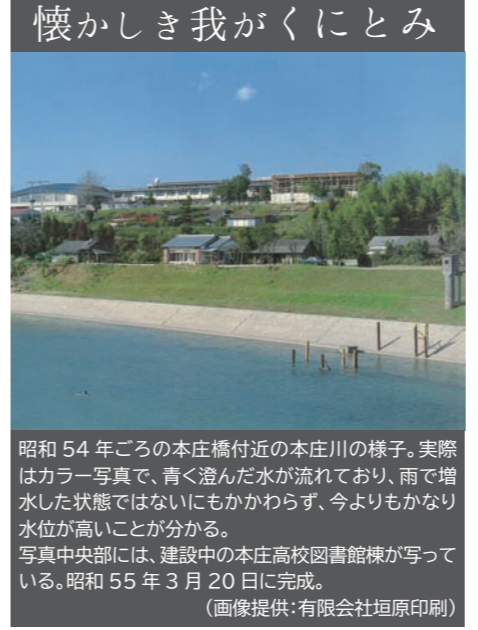
昭和54年ごろの本庄橋付近の本庄川の様子。実際はカラー写真で、青く澄んだ水が流れており、雨で増水した状態ではないにもかかわらず、今よりもかなり水位が高いことが分かる。写真中央部には、建設中の本庄高校図書館棟が写っている。昭和55年3月20日に完成。(画像提供:有限会社垣原印刷)
