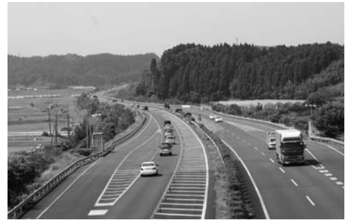
スマートインターチェンジ建設予定地
