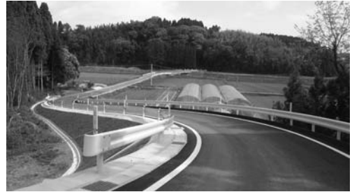
道路改良「飯盛永田線」
