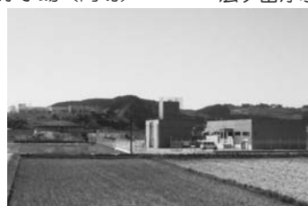
森永浄水場（上水）
