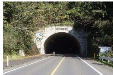
本庄トンネル
