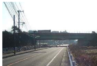
東九州自動車道
