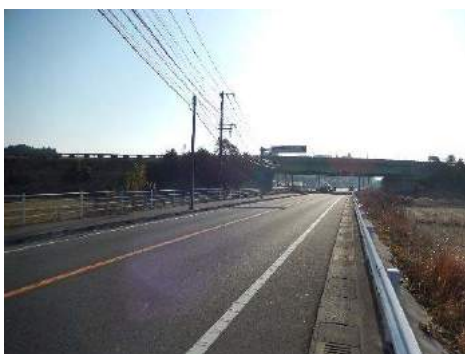
東九州自動車道
