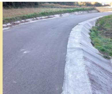
張りコンクリートによる路肩整備
