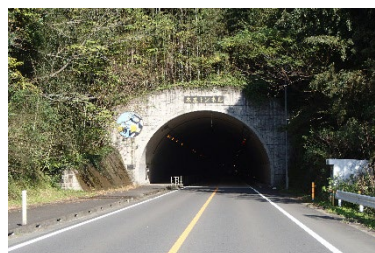
本庄トンネル
