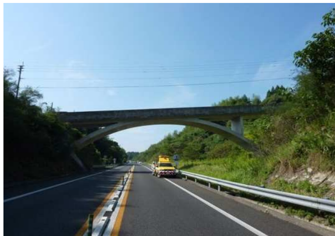
図 10 道路を跨ぐ橋梁の例（国富町管理 亀の甲谷橋）
