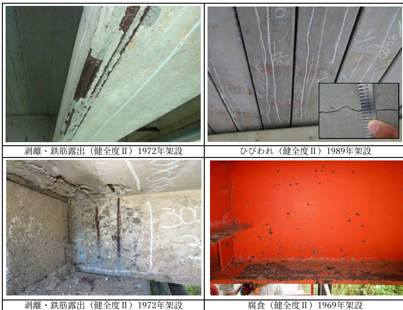
図 6 損傷状況
