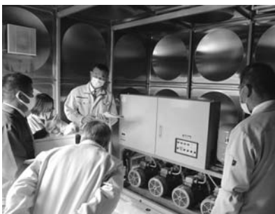
〔馬渡配水池加圧ポンプ室〕
