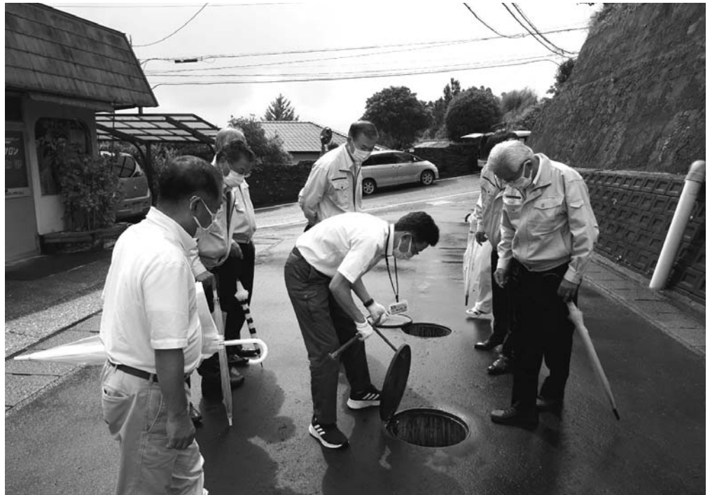
【現地調査：防火水槽新設(塚原＝日之出団地)】
