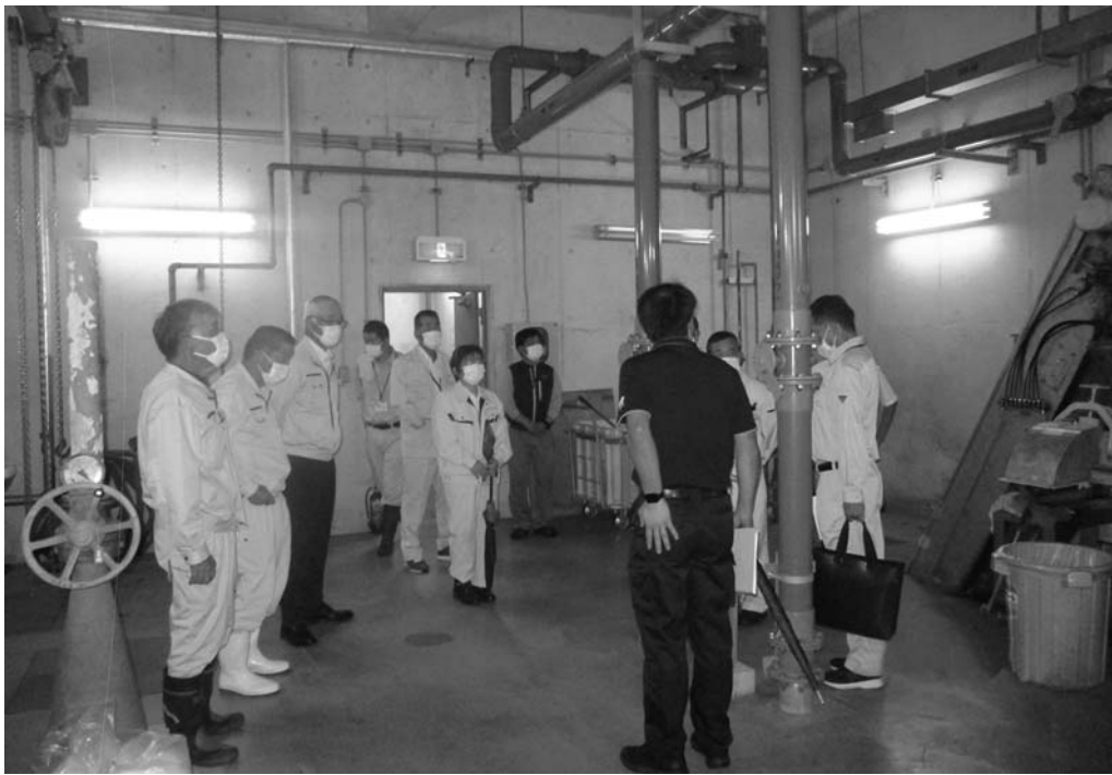
【現地調査：浄化センター内設備更新】
