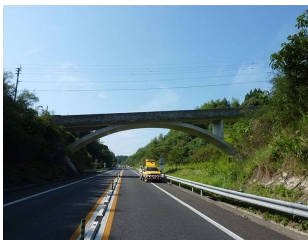
図 9 道路を跨ぐ橋梁の例（国富町管理 亀の甲谷橋）
