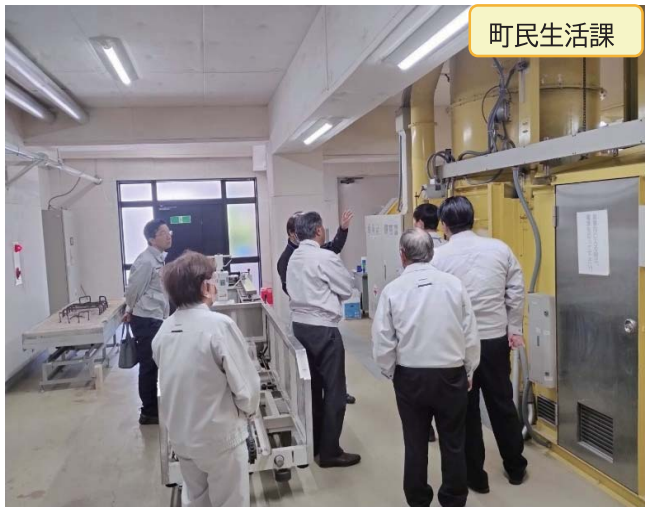
東諸葬祭場の火葬炉修繕箇所
