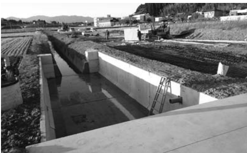
現在、岩知野地区で実施されている大排水の整備。完成は令和6年3月の予定。
