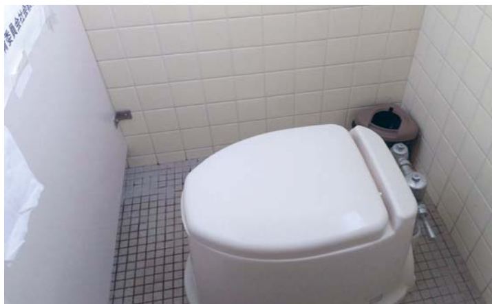
武道館のトイレは狭くて、使いづらい
