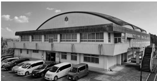
体育館としての利用を終えた元中央体育館、解体時期を含め、今後の利用が気になるところ。
