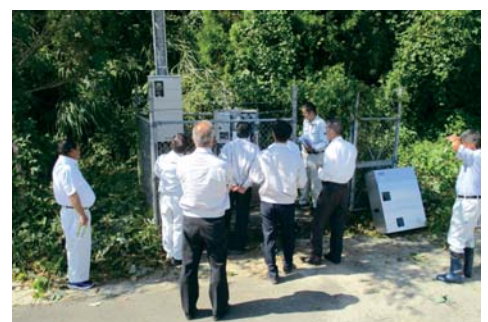
【現地調査：加圧ポンプ設備更新工事】
