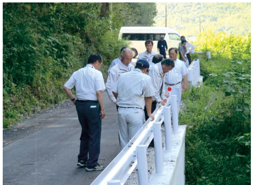
【現地調査：公共施設災害復旧工事(町道仏喰田大久保線)】
