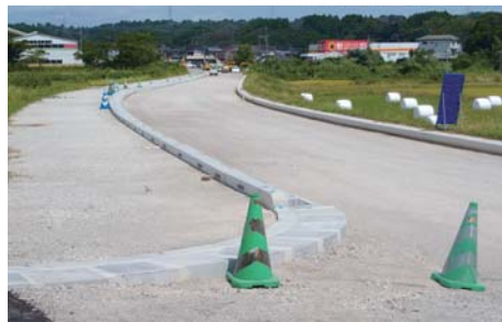
【工事中の県道木脇高岡線】 早期完成に期待する。
